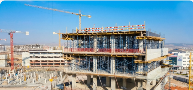
Blok Bazlı Kaba İnşaat ve Yapısal İskelet Süreci
