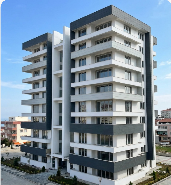
Estetik Dış Cephe Kaplaması ve Balkon Detayları
