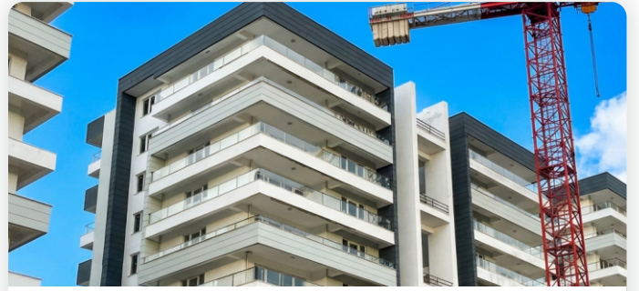
Çok Bloklı Lojman Yerleşkesi ve Şantiye Uygulama Süreci
