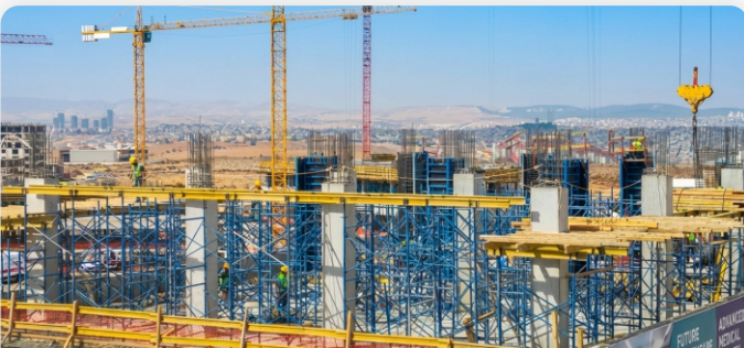
Endüstriyel Kalıp Sistemleri ve Taşıyıcı Kolon İmalatı
